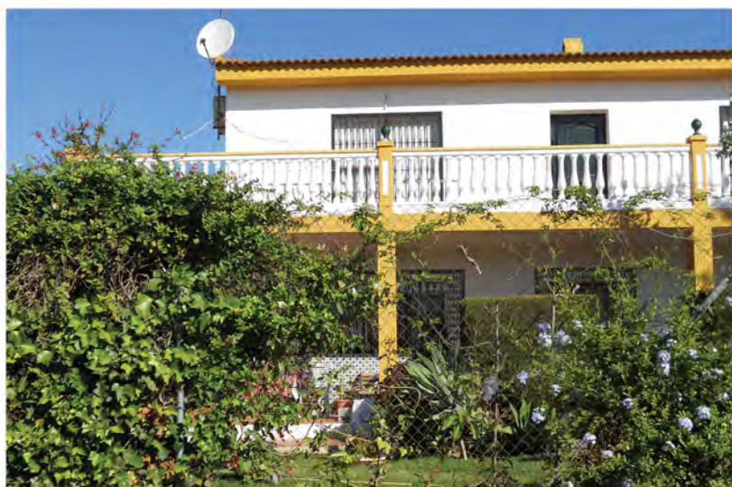
Vivienda aparentemente bien cuidada.
