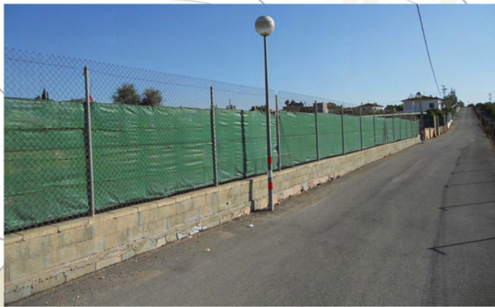
Acceso al HRD poco amable con el entorno.
