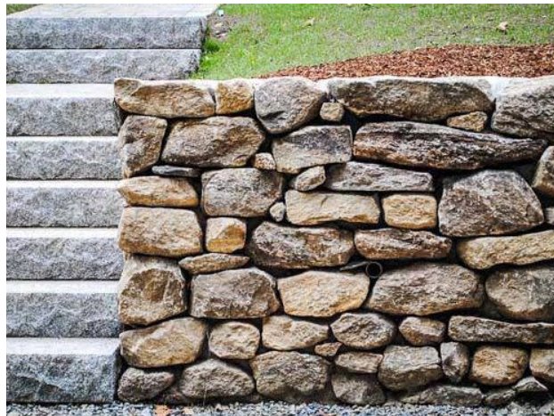
Muro de piedra seca.
