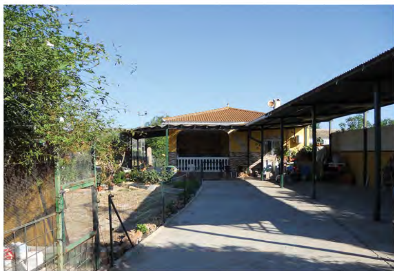
Entrada a la parcela con una pérgola.
