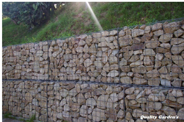
Muro en gaviones de malla soldada.
