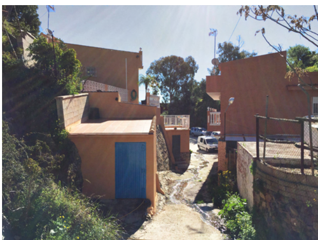
Viviendas situadas sobre zona inundable en Los Pintados
