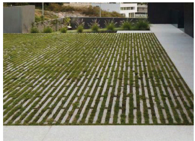
Pavimento mixto en zona de aparcamientos.
