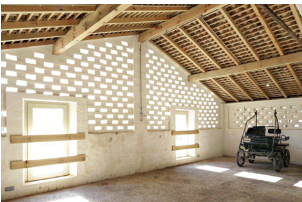
Utilización de celosías y madera para acondicionar distintos espacios.
