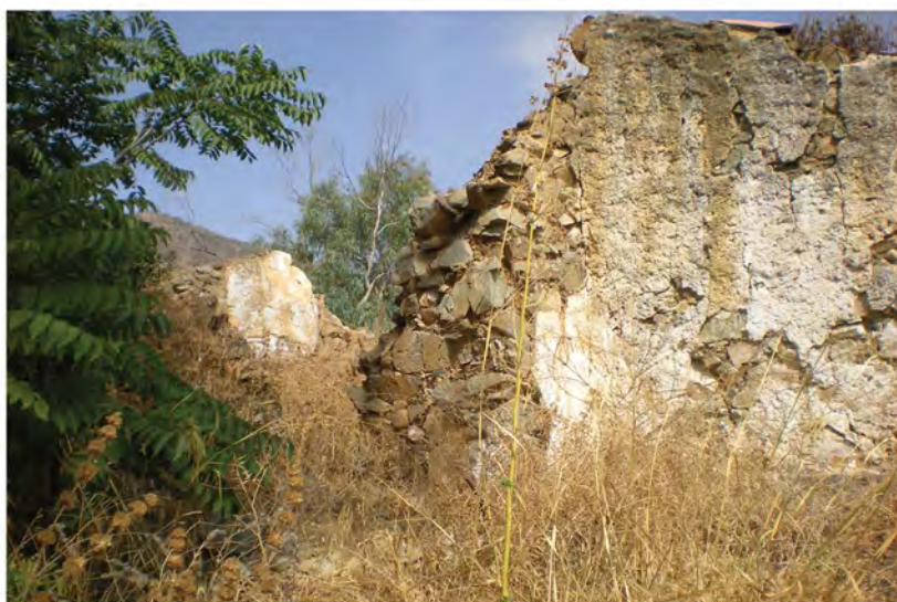
Muros contruidos con piedra del lugar.
