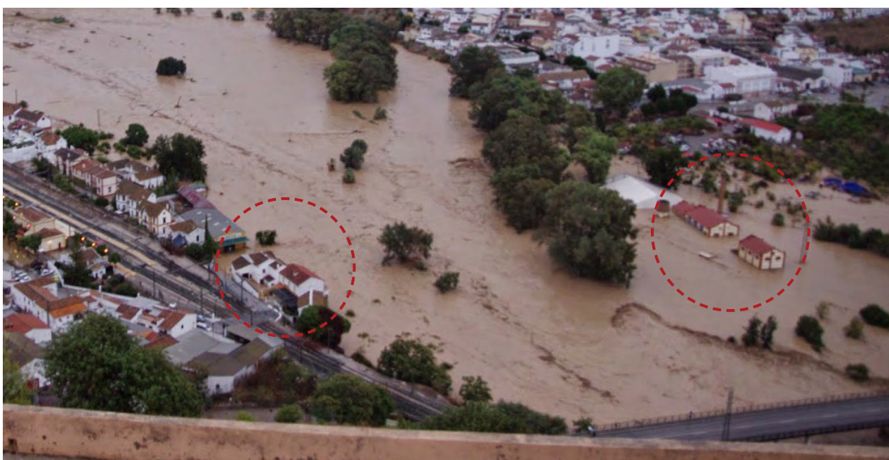
Edificaciones situadas sobre zonas inundables que terminaron inundadas tras una tormenta en 2014 en Málaga
