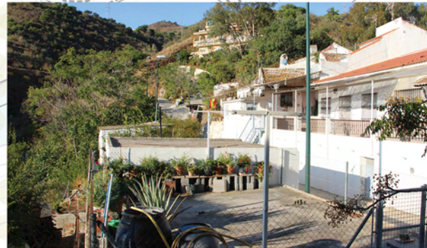
Depósito semi-enterrado para almacenar agua
