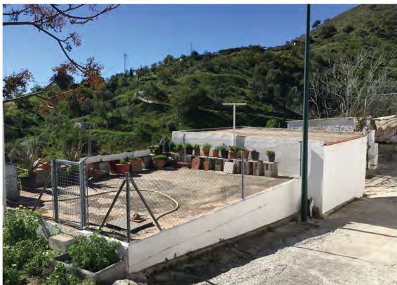
Aljibe para dar suministro de agua a los habitantes de Los Pintados.
