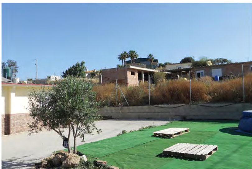
Muro no integrado en el entorno.
