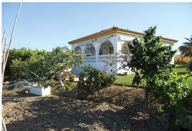
Ausencia de sistema de placas solares y recogida de aguas pluviales.
