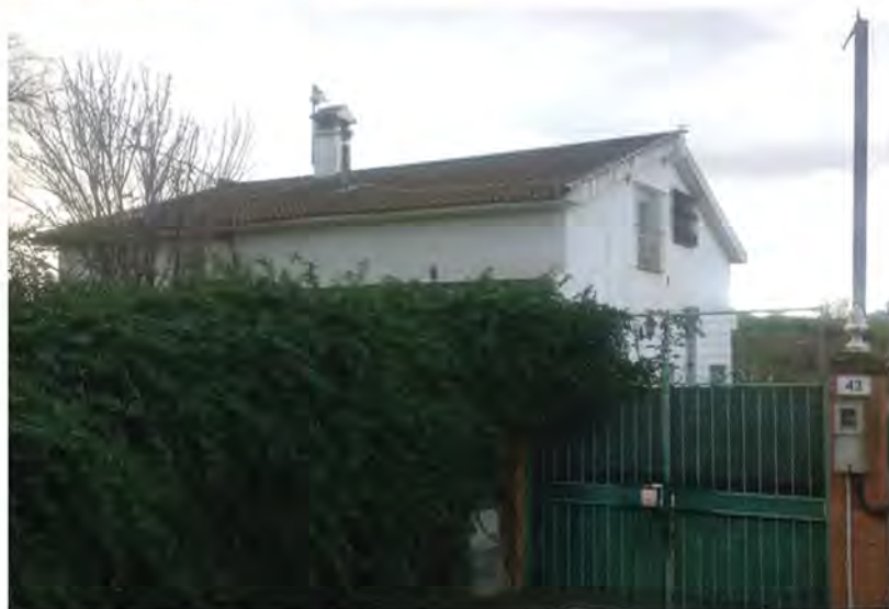
Vallado totalmente opaco, y vivienda con diversas modificaciones de huecos en fachada.
