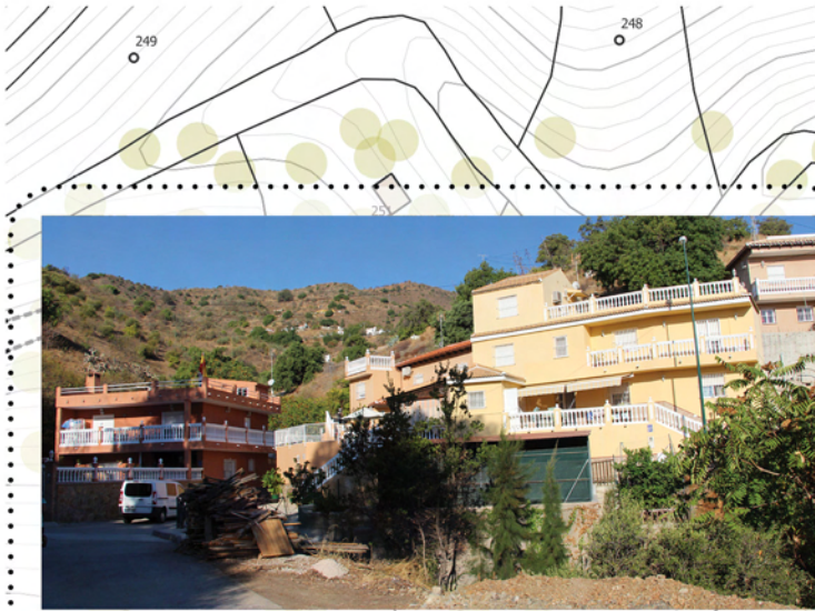
Viviendas situadas en zona inundable
