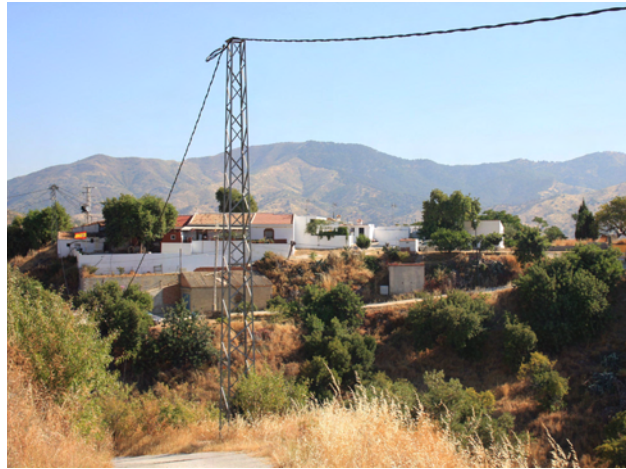
Falta de integración de la infraestructura eléctrica en el paisaje
