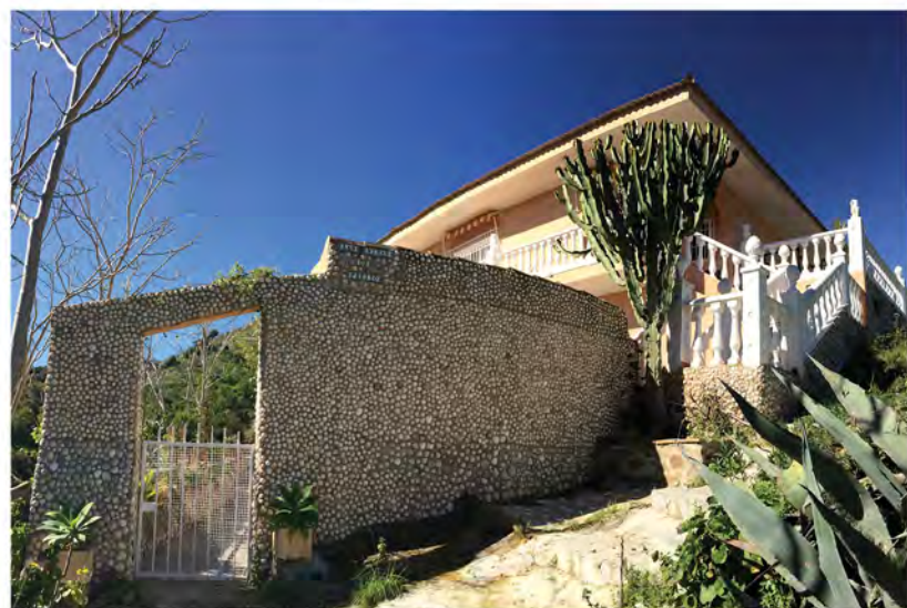
Muro construido de forma artesanal.
