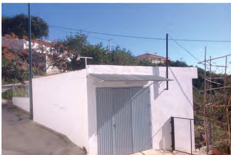
Vista de acceso al equipamiento.
