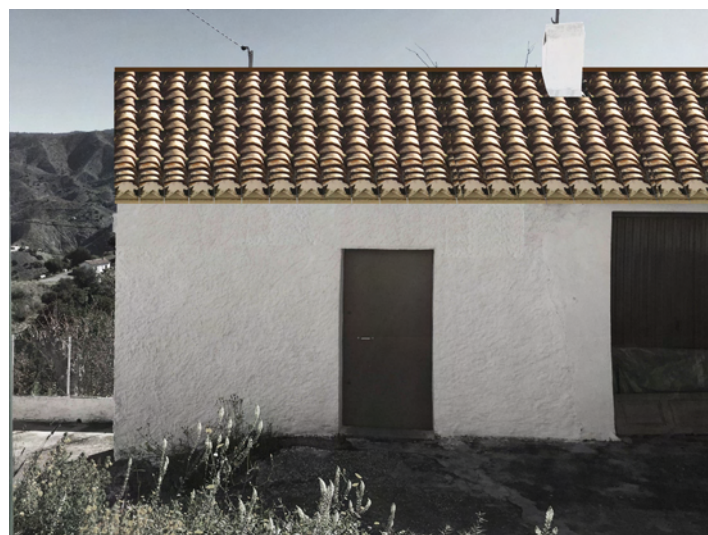
Solución II. Cubierta inclinada de teja
