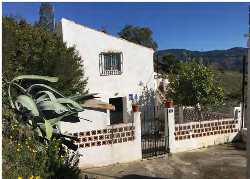
Vivienda de construcción tradicional.
